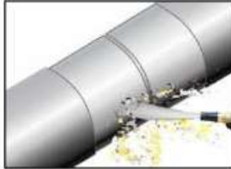
Figura 2: Limpieza abrasiva a metal casi-blanco NACE 2/ SSPC-SP10
