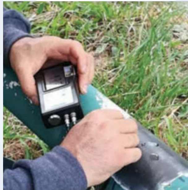
Evaluación directa de la corrosión interna (ICDA)
