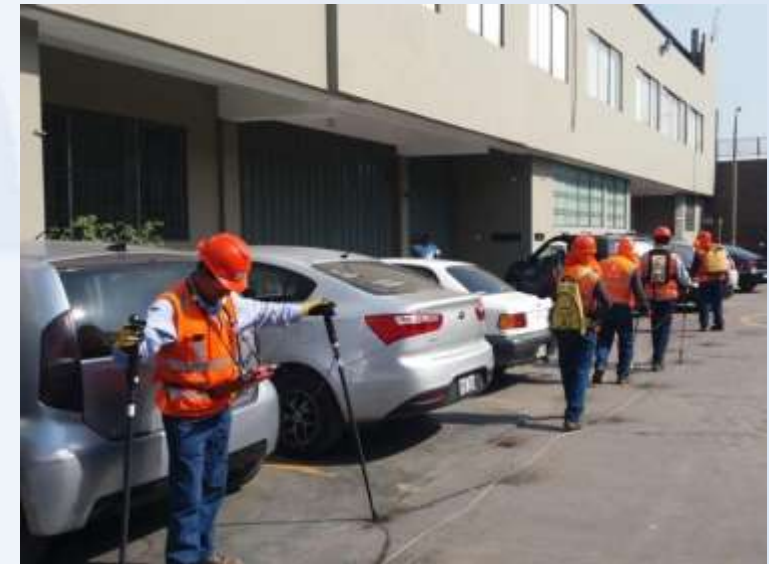
Evaluación directa del agrietamiento por corrosión por esfuerzo (SCCDA)
