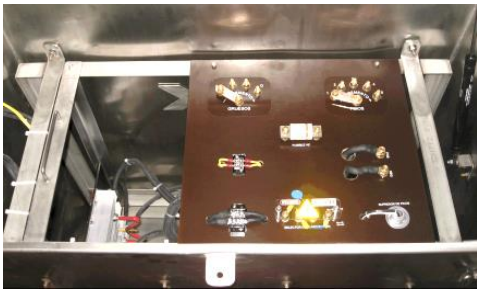
Fig. 6 Vista superior del rectificador refrigerado por aceite
