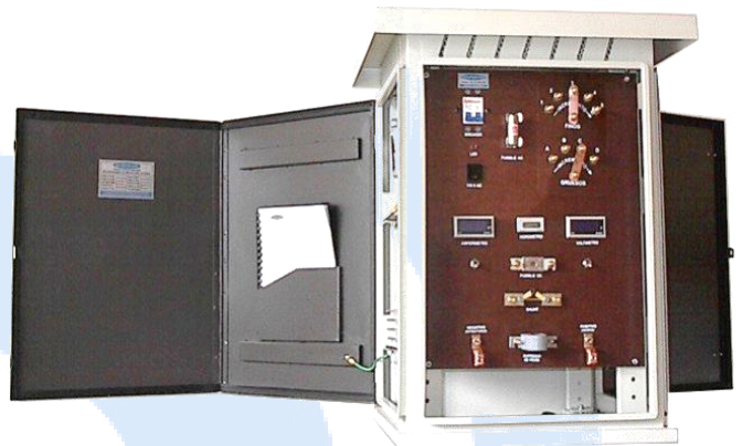
Fig. 1 Rectificador estándar con refrigeración por aire
