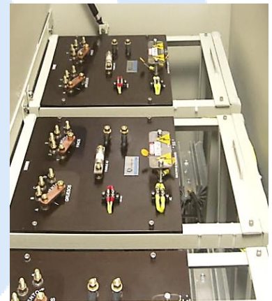
Fig. 7 Vista superior rectificador especial 3 en 1 refrigerado por aceite
