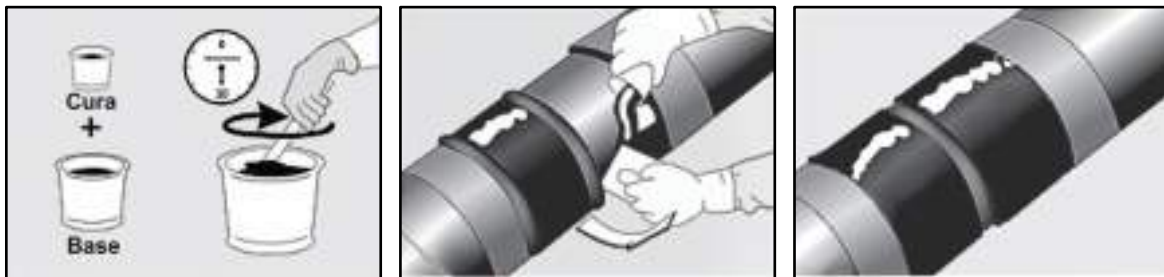
Figuras: 4, 5 y 6 Aplicación del tecnosleeve-epoxy
